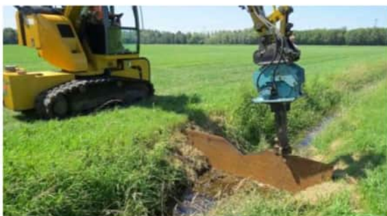
Figuur 2-1 Stalen (rij)plaat in de watergang
