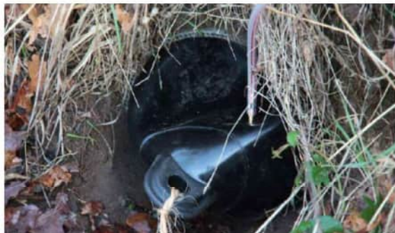
Figuur 2-3 Ballonafsluiter met ventiel
